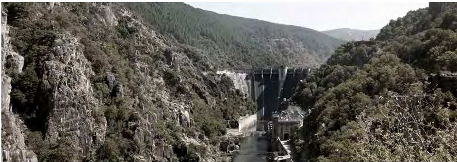
Presa de San Esteban del Sil, Nogueira de Ramuín (Ourense), 1945-1957 Dragados y Construcciones
