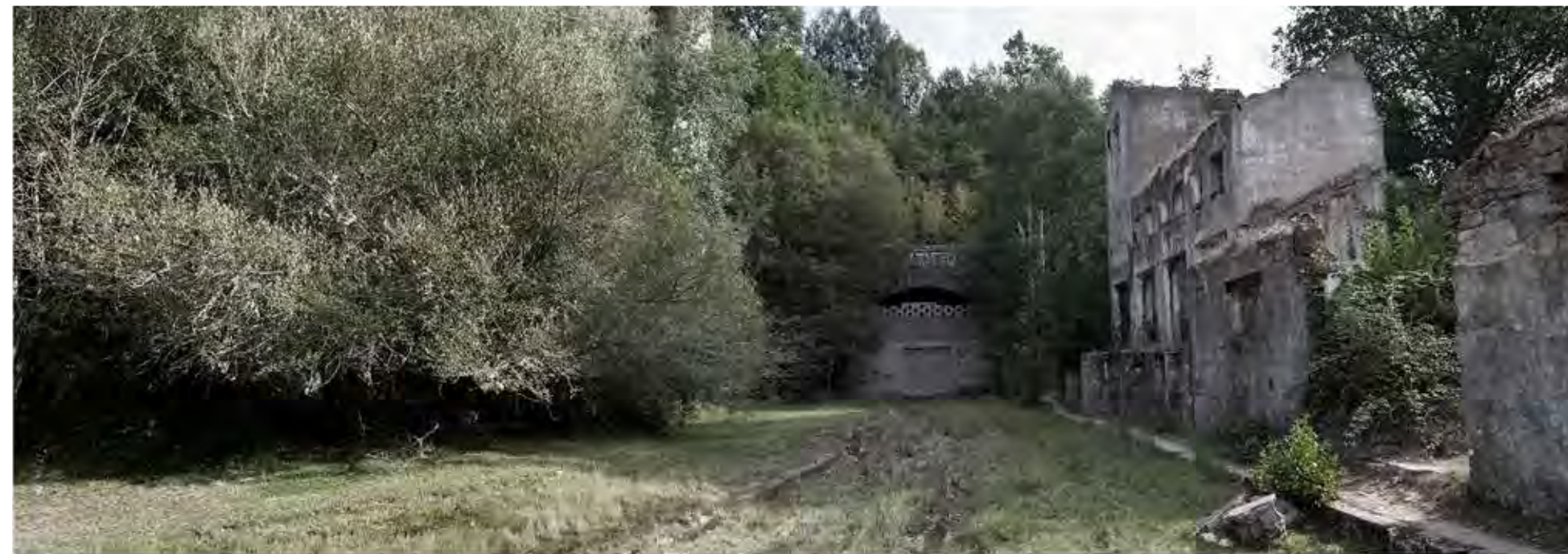
FFCC Santander-Mediterráneo, Túnel de la Engaña, Pedrosa de Valdeporres (Burgos), 1942-1945 Ferrocarriles y Construcciones ABC
