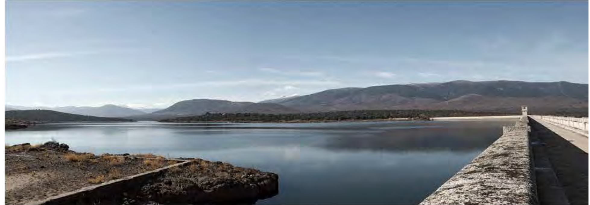
Presa de Riosequillo, Buitrago del Lozoya (Madrid), 1946-1952 Constructora Gutiérrez Oliva y Bourne, S.A.
