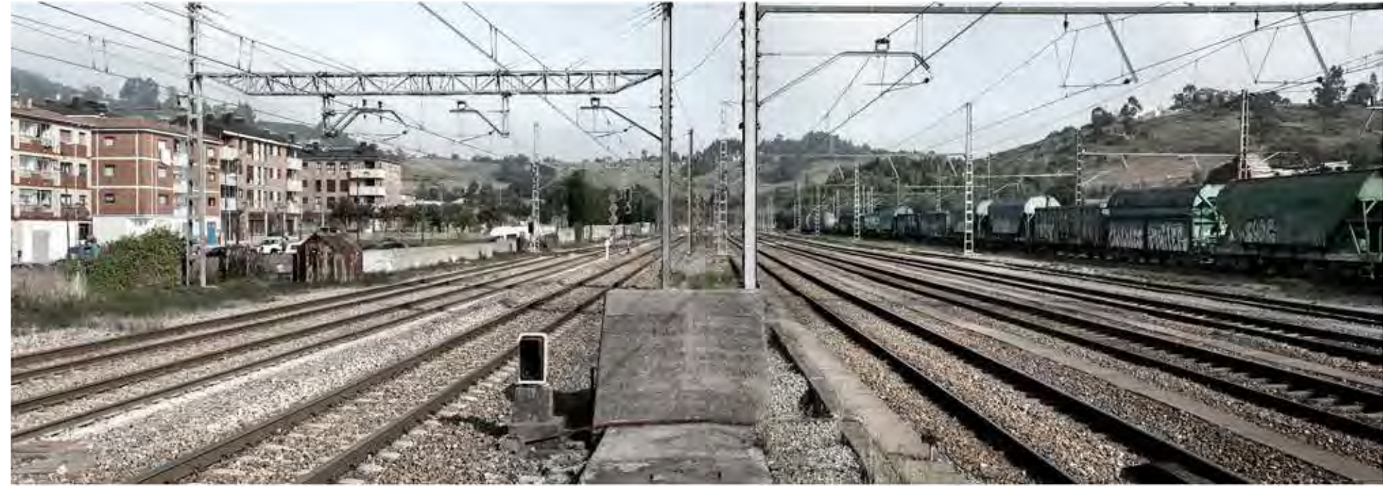
FFCC Tudela Veguín-Lugo de Llanera (Oviedo), 1947-1956 Ingeniería y Construcciones Marcor, S.A.
